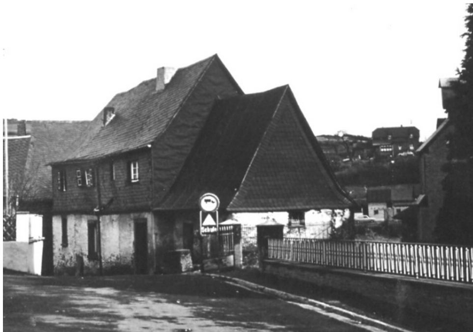
Das alte Müllerbacher Pfarrhaus, wie es noch in den 80er Jahren des 20. Jahrhunderts stand. Die beengten Räumlichkeiten, mit denen sich der Offizier eines preußischen Garderegiments bei seiner Einquartierung im großen Manöver 1887 begnügen musste, sorgten indirekt für den Neubau des heutigen Backstein-Pfarrhauses in Müllenbach.
