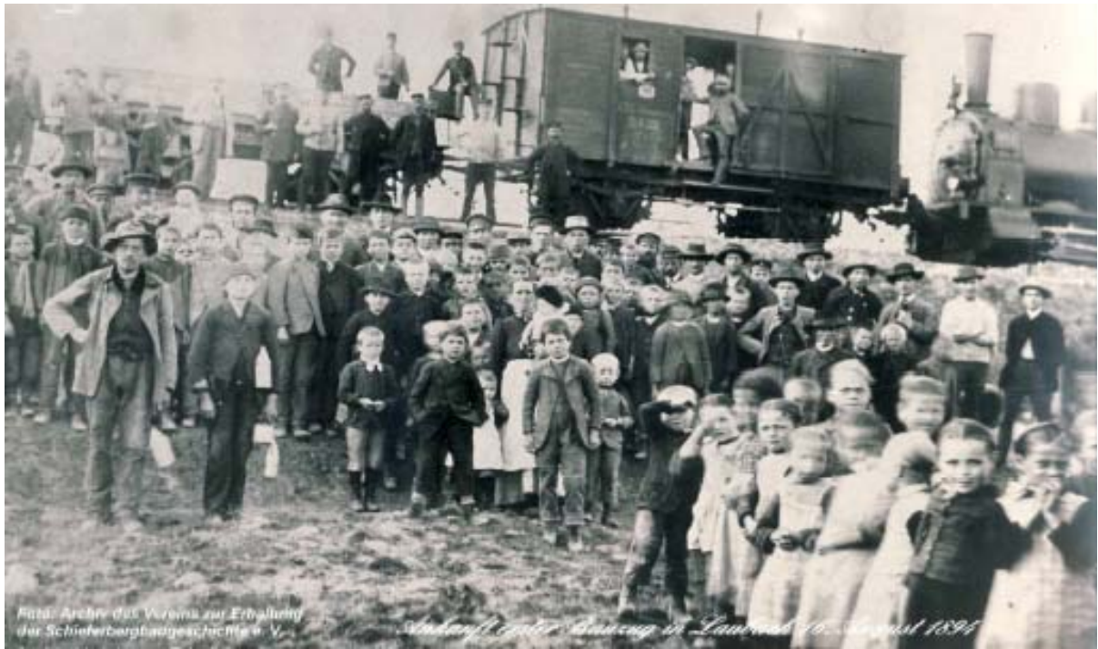
Der erste Bauzug erreichte Laubach am 16. August 1894.
